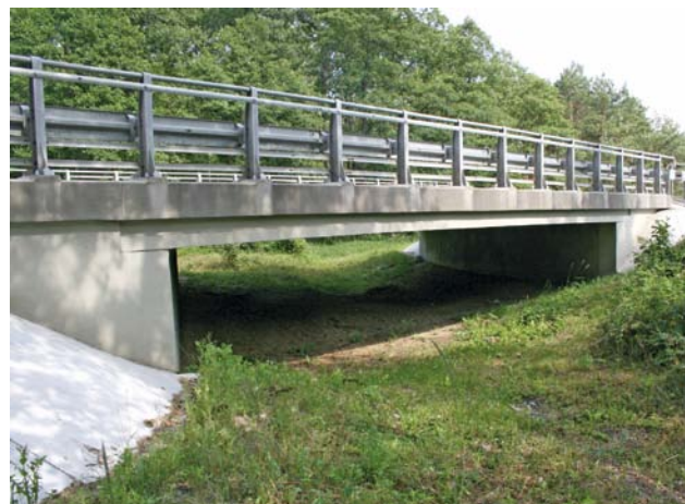
Fot. 75. Przejście przeznaczone dla małych ssaków o korzystnych rozwiązaniach dla płazów
