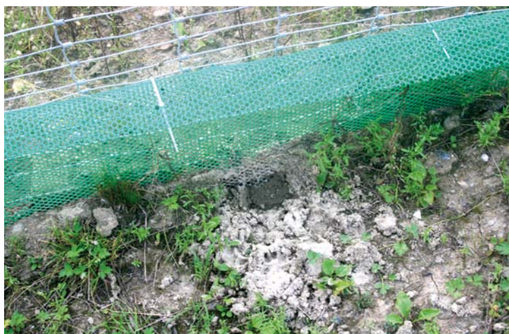
Fot. 47. Nieudana próba podkopu – siatka zakopana na odpowiednią głębokość
