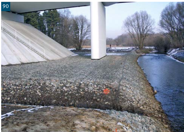
Fot. 84. Mały most z półkami niedostosowanymi do potrzeb przemieszczania się płazów
