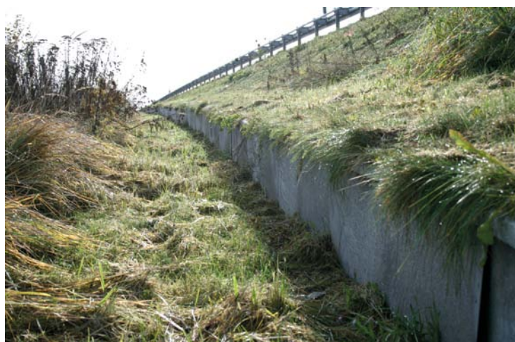
Fot. 51. Pozostawienie skoszonej trawy na powierzchni bieżni ogranicza skuteczność ogrodzenia i ułatwia ekspansję roślinności
