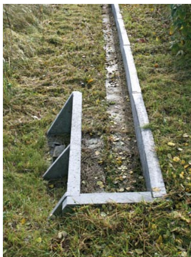
Fot. 19. Właściwe zakończenie ogrodzenia ochronno-naprowadzającego
