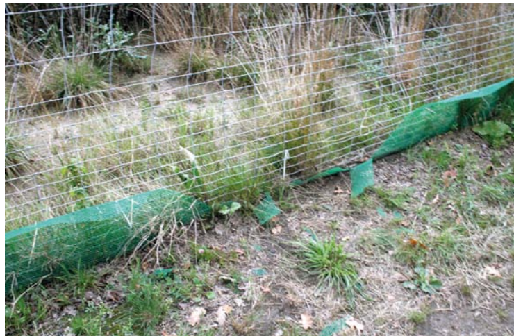
Fot. 42. Często spotykane uszkodzenia siatek polimerowych
