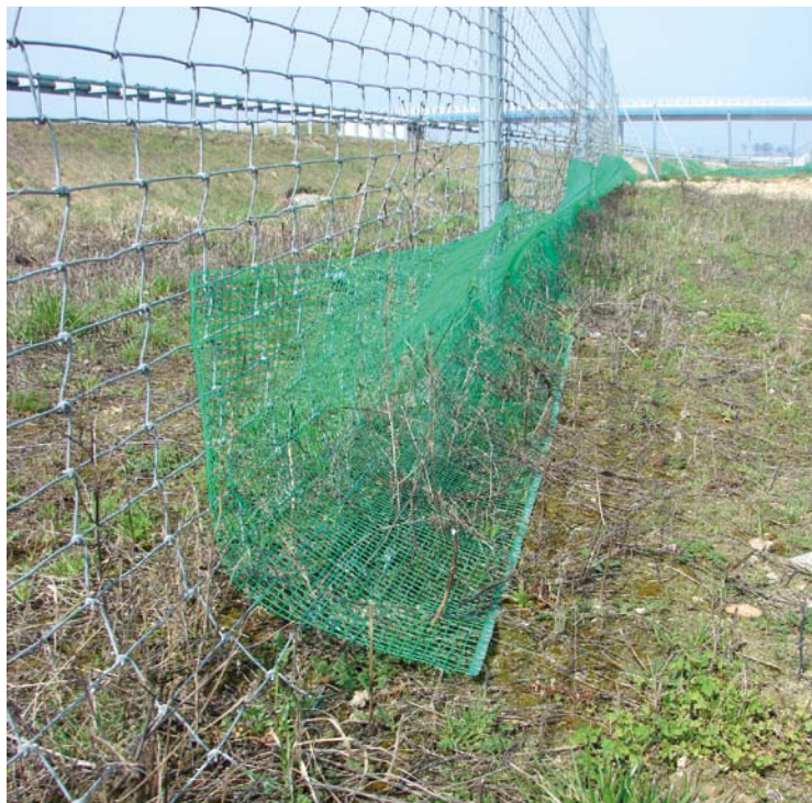
Fot. 46. Brak zakopania siatki w grunt powoduje nieszczelność ogrodzenia przy dolnej krawędzi
