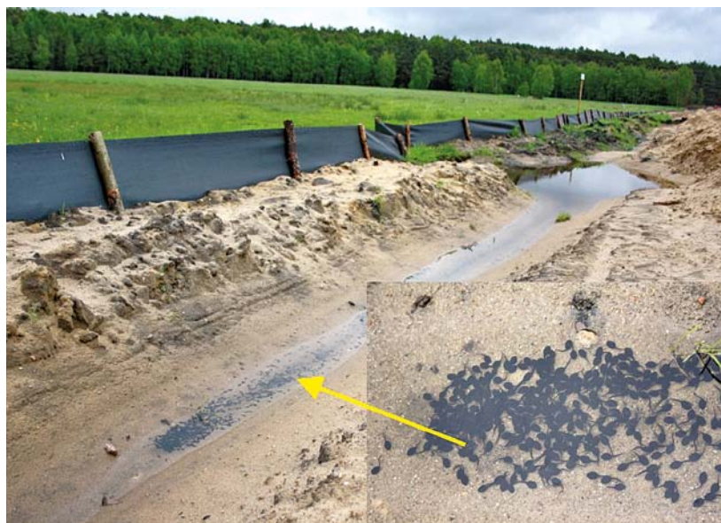
Fot. 104. Nadzór herpetologiczny musi systematycznie kontrolować teren budowy drogi, aby nie dopuścić do złożenia jaj przez płazy i do wylęgu kijanek, których wyłowienie jest problematyczne (tu – kijanki ropuchy szarej w pasie drogowym)
