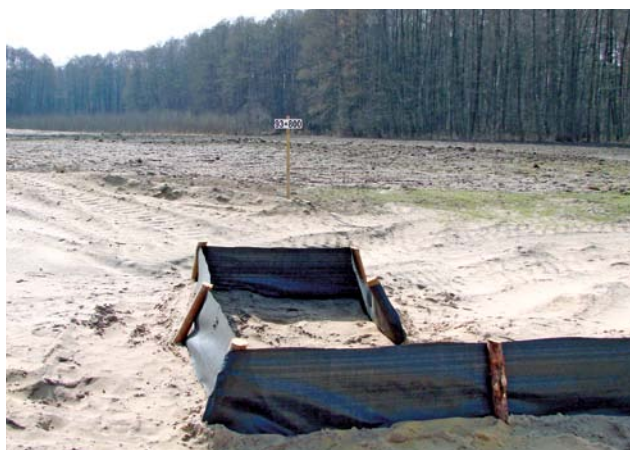
Fot. 55. Zakończenie ogrodzenia tymczasowego w kształcie litery „U”
