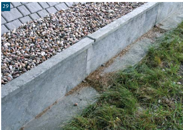
Fot. 25. Ogrodzenie z prefabrykatów betonowych firmy Zieger – droga krajowa nr 8 w okolicy Budziska Fot. 26. Ogrodzenie w prefabrykatów polimerbetonowych firmy ACO – droga lokalna w Suwalskim Parku Krajobrazowym Fot. 27. Ogrodzenie z płyt stalowych firmy Maibach – autostrada A4 (Niemcy) Fot. 28. Ogrodzenie z płyt polimerowych firmy Beilharz – autostrada A1 w okolicy węzła Rybnik Fot. 29. Ogrodzenie z prefabrykatów polimerowych firmy Zunklei – autostrada A20 (Niemcy)
