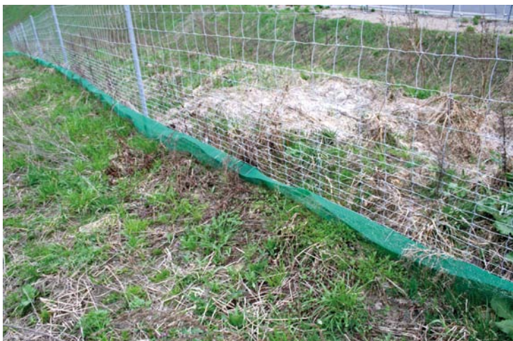
Fot. 40. Zbyt głębokie wkopanie w grunt może znacząco ograniczyć efektywną wysokość ogrodzenia
