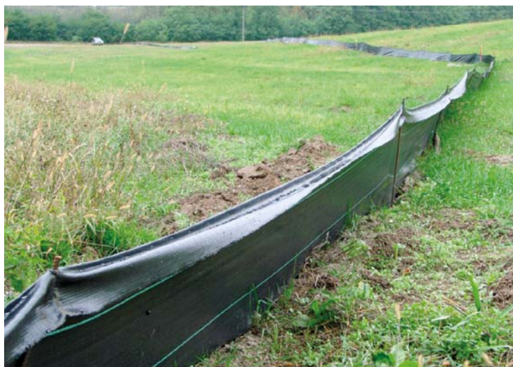
Fot. 53. Ogrodzenie tymczasowe z geotkaniny wokół placu budowy
