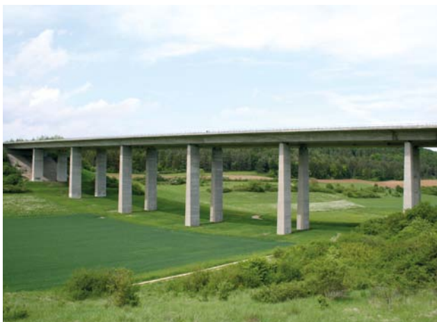
Fot. 74. Estakada zapewniająca ciągłość siedlisk płazów
