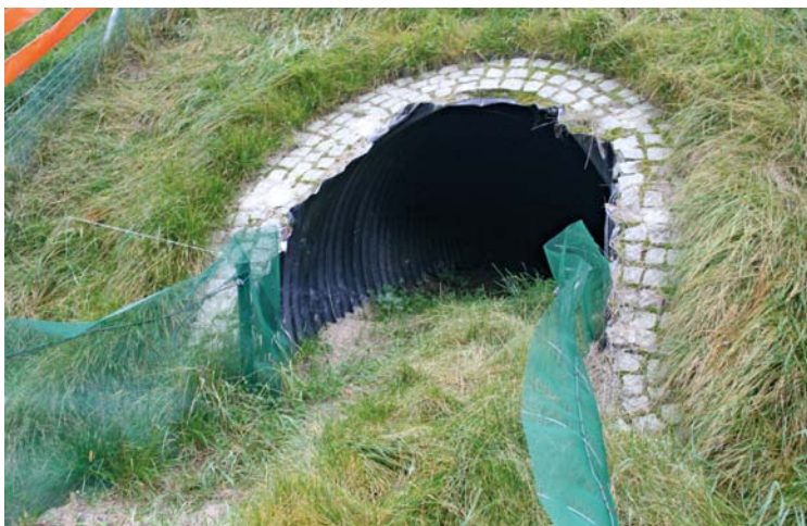
Fot. 48. Niestabilne wykonanie odgięcia górnej krawędzi
