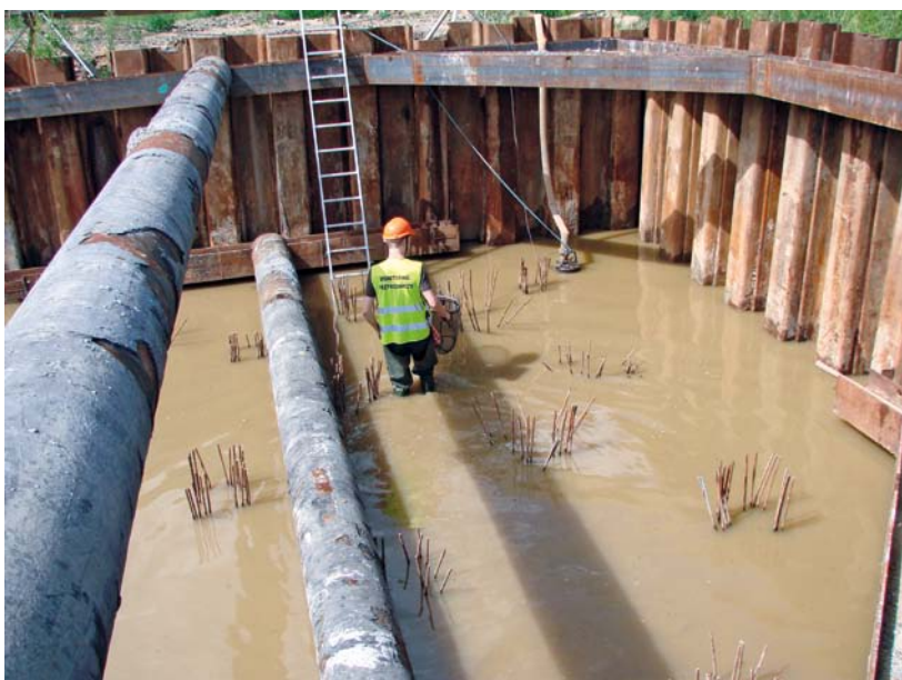
Fot. 106. Ważnym zadaniem nadzoru herpetologicznego jest okresowa kontrola wszystkich pułapek na terenie budowy (tu: wykopy pod podpory wiaduktu)
