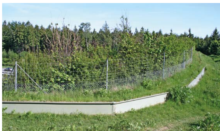
Fot. 16. Ogrodzenie ochronno-naprowadzające wzdłuż ekranów w formie wałów ziemnych
