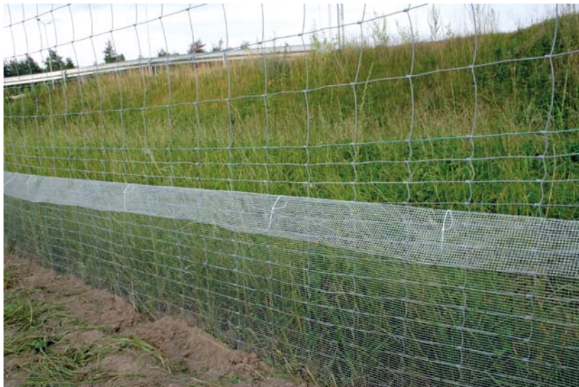
Fot. 21. Ogrózenie ochronne wykonane z siatki stalowej
