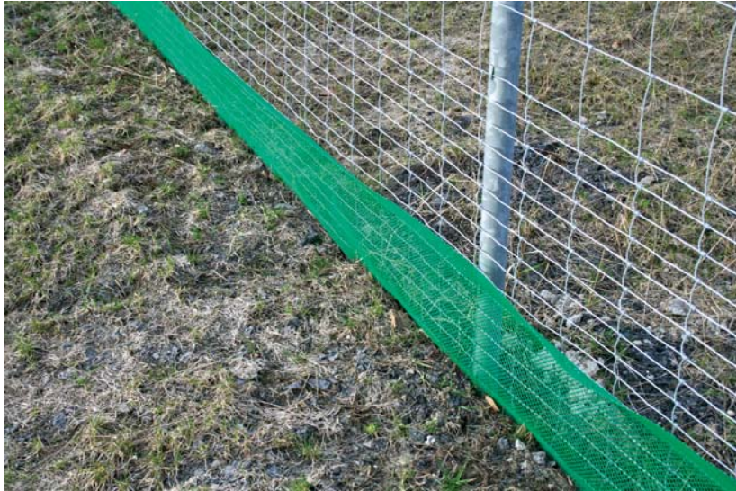
Fot. 20. Ogrózenie ochronne wykonane z siatki polimerowej
