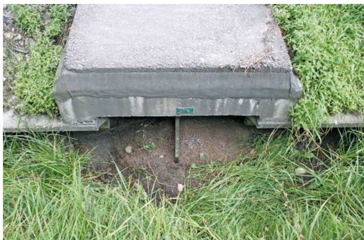
Fot. 66. Powierzchnia przejścia pokryta gruntem zapewniającą odpowiednią wilgotność
