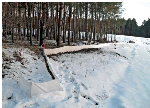
Fot. 56. Ogrodzenie tymczasowe należy ustawić przed rozpoczęciem migracji wiosennych (tu: 15.03.2010)
