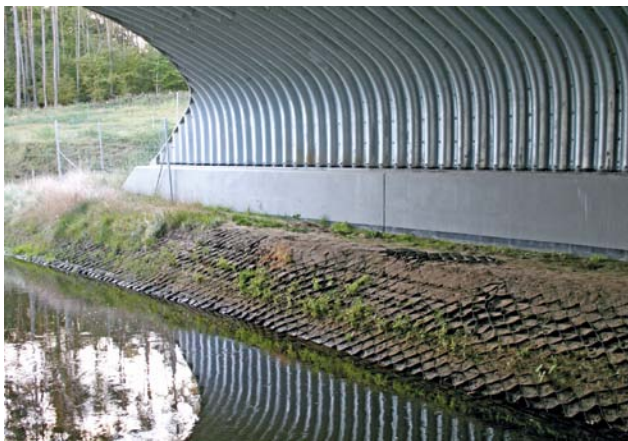
Fot. 97. Geosyntetyki są dobrym materiałem do umacniania koryt, należy jednak zadbać o szczelne pokrycie ich gruntem
